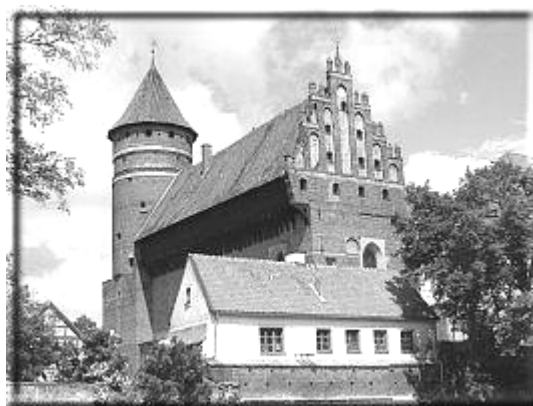
7. Zamek w Olsztynie – skrzydło południowo - wschodnie
